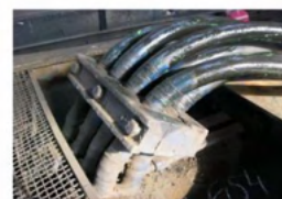
Foto nr. 24 stare normală a jugului de fixare a cablurilor la intrarea în motorul de tracțiune
