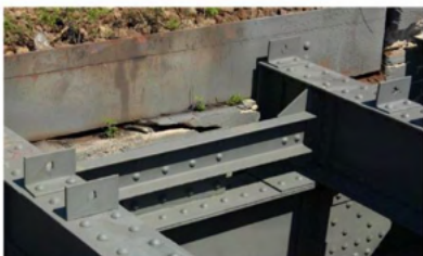
foto nr. 16 - distrugerea părții superioare a culeei C2 datorită împingerii exercitate de tablierul III în urma șocului primit de la tablierul II
