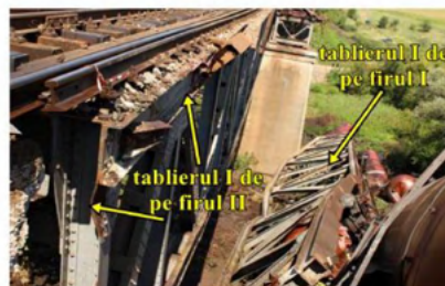
foto 17: - firul II de circulație - loviri ale capătului tablierul I - firul I de circulație - tablierul I este căzut la baza infrastructurii viaductului
