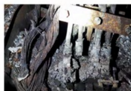
Foto nr. 23 stare existentă a jugului de fixare a cablurilor la intrarea în motorul de tracțiune
