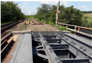
Foto nr. 8- Terasamentul din spatele culeei Banu Mărăciine (culeea C2) șine, contrașine interioare și traverse sunt scoase din cale
